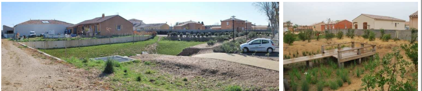
Bassin de rétention paysager en entrée de lotissement et noues aménagées au cœur d'un espace public dans un lotissement.
